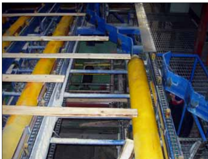
4. Mise en butée vers un escalier
