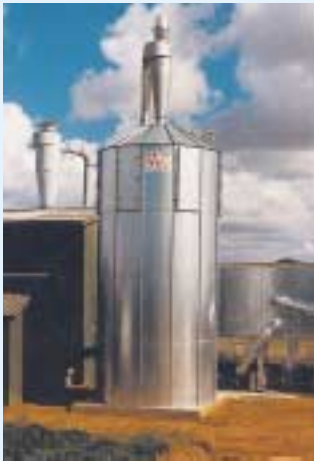
96 m 3 silo for fyringsanlæg og tømning af sugebil.
